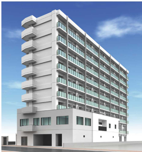
鉄筋コンクリート造9階建（イメージ）
